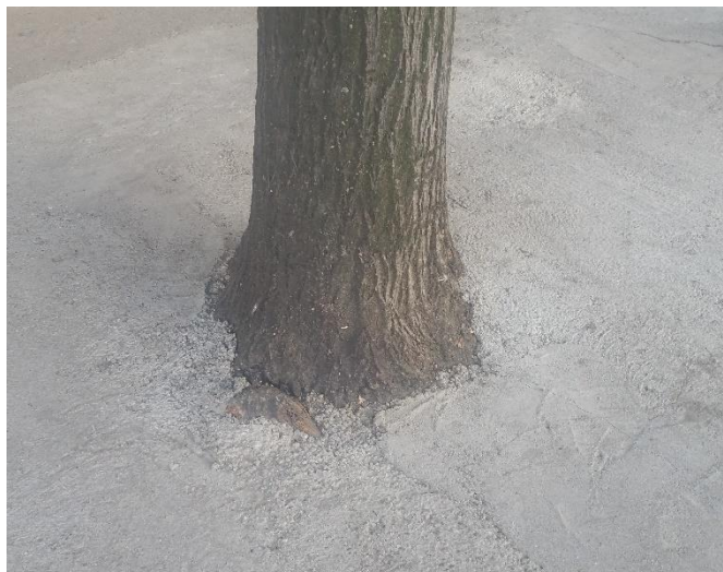
Слика 1. Стебло кое е по целиот обем на кореновиот врат е во контакт со бетон
